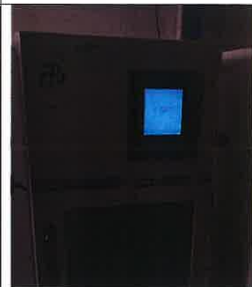
3. 总排口 COD 监测设备
